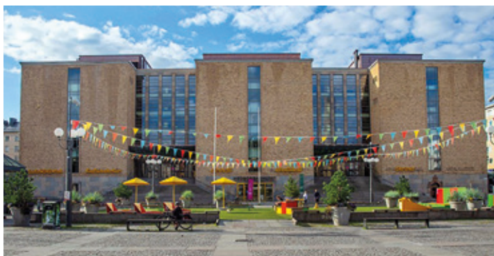
Medborgarhuset vid Medborgarplatsen har öppnats igen efter den omfattande renoveringen och nu är teleslingor installerade i alla allmänna utrymmen. Alla är ännu inte aktiverade och vi har inte haft tillfälle att testa.
